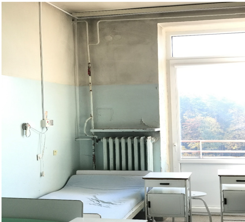
Zdjęcie 4. Grzejnik w pokoju łóżkowym do wymiany
