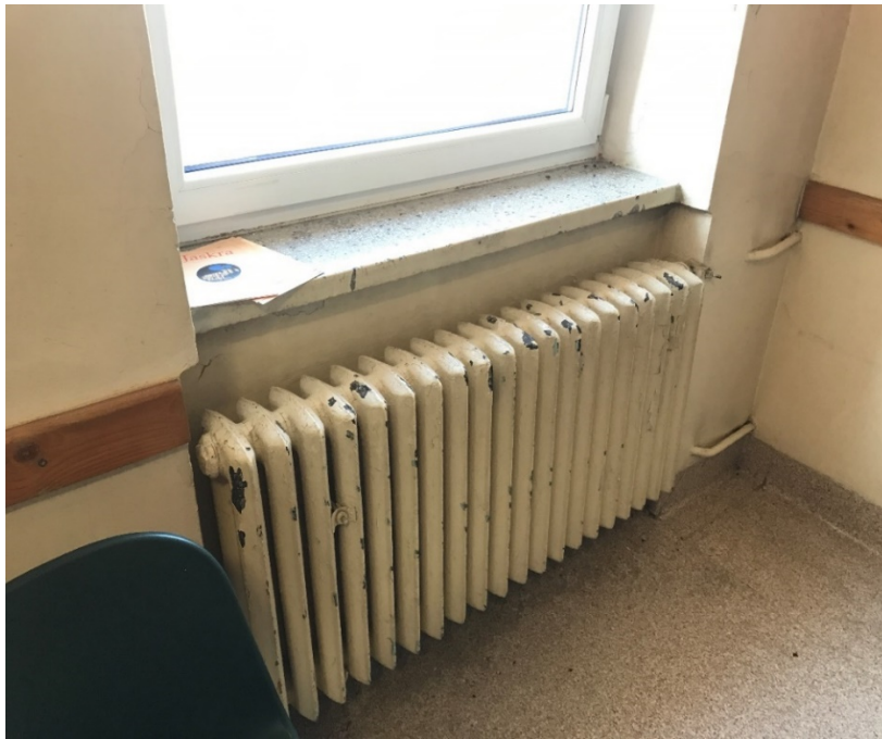
Zdjęcie 3. Grzejnik żeliwny do wymiany
