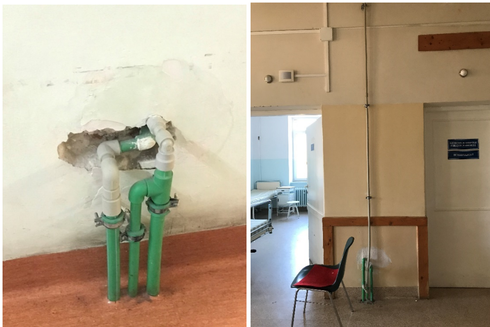
Zdjęcie 5. i 6. Piony instalacji CWU, cyrkulacji i zimnej wody na poziomie +3
