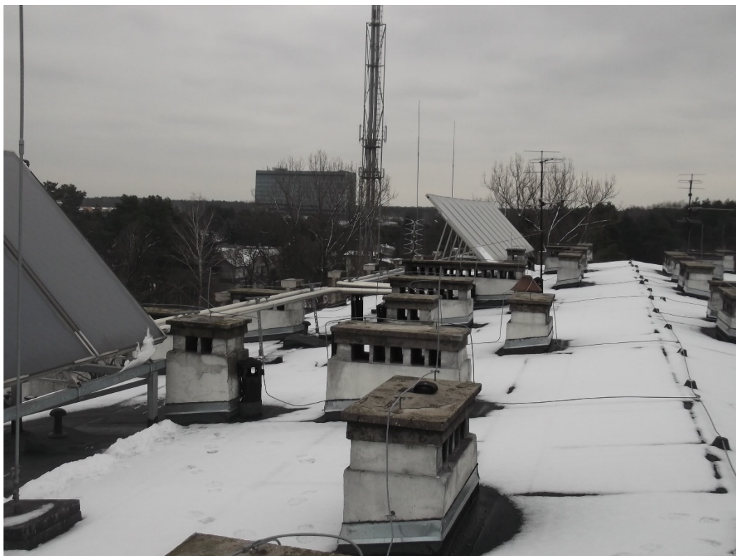
Zdjęcie 2. Wyloty wentylacji grawitacyjnej oraz panele instalacji solarnej na dachu
