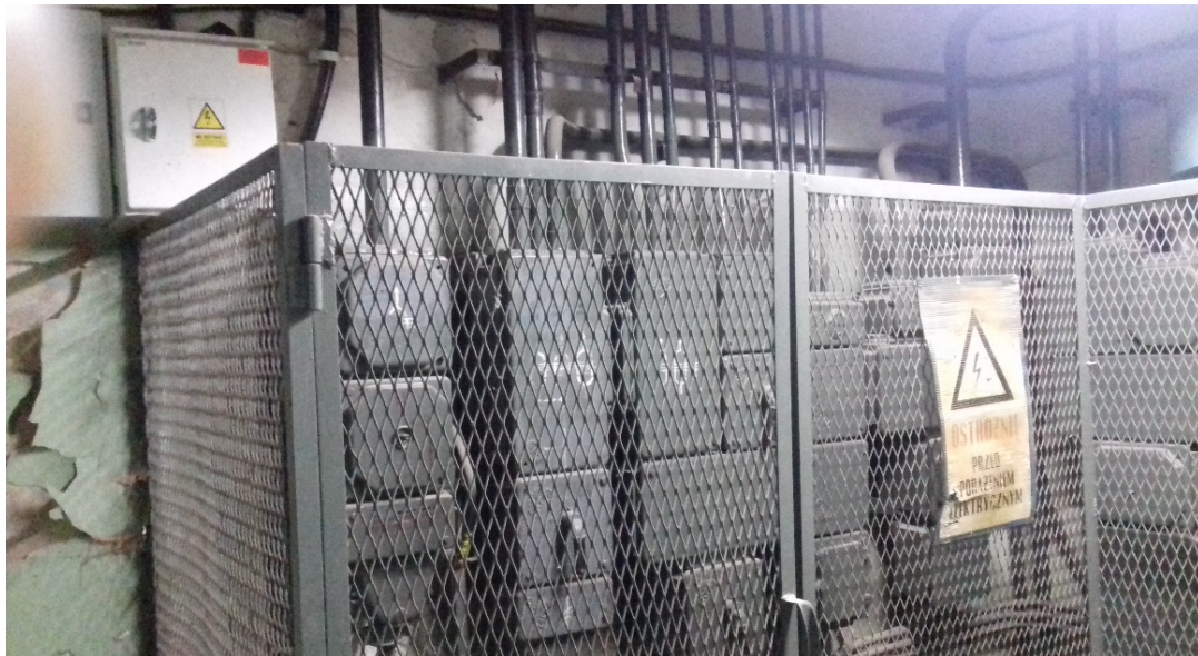
Zdjęcie 4. Rozdzielnica elektryczna żeliwna (modułowa) na -1 kondygnacji. Cd dla foto nr 1.
