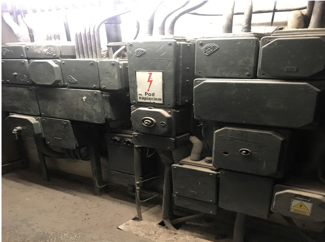
Zdjęcie 3. Rozdzielnica elektryczna skrzynkowa na -1 kondygnacji – rozszerzenie wizualne do fot nr 1.
