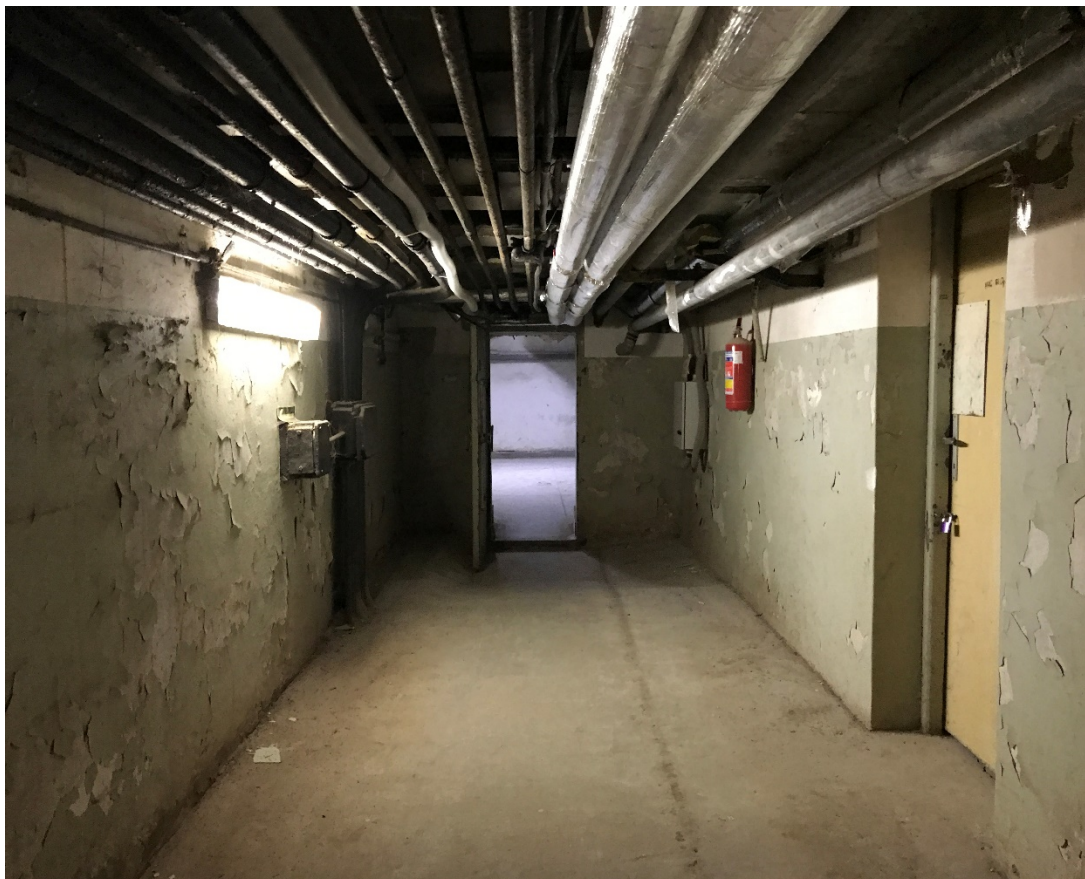
Zdjęcie 2. Korytarz techniczny – instalacje elektryczne prowadzone w rurkach instalacyjnych stalowych – model lata 60/70. Konieczne – zaprojektowanie i zastąpienie istniejących tras ciągami koryt otwartych o różnej odporności ogniowej ( w zależności od potrzeb) i wypełnienia ich projektowanymi kablami z podziałem na różne rodzaje instalacji. WYMÓG KONIECZNY.
