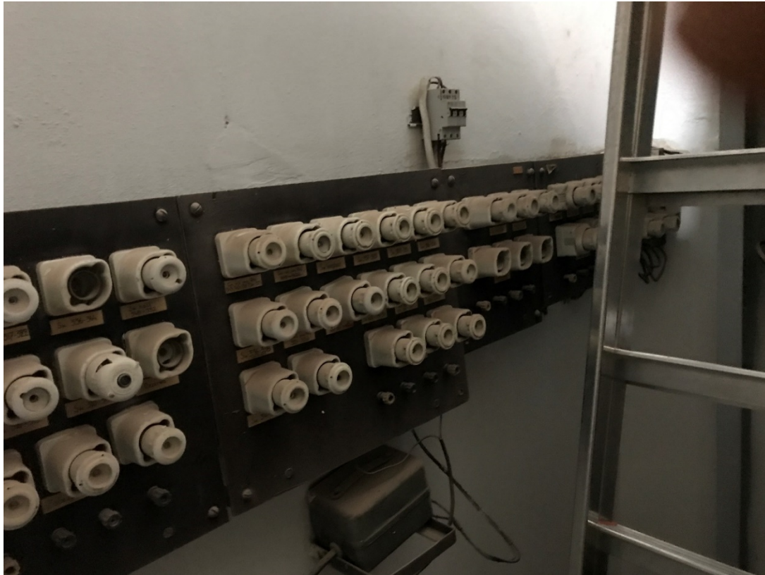
Zdjęcie 5. Niezabudowana rozdzielnica wyposażona w bezpieczniki na +3 kondygnacji.
