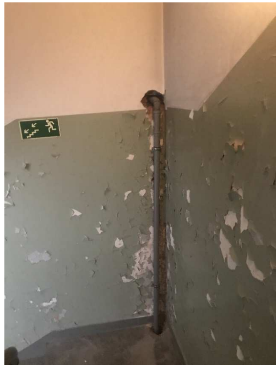
Foto. 4. Brak przejścia ppoż. przez ścianę stanowiącą obudowę klatki K1C – do usunięcia w etapie I
