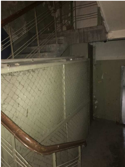
Foto. 5. Pomieszczenie w K1C bez obudowy w klasie (R)EI 60 – do usunięcia/wydzielenia w etapie I
