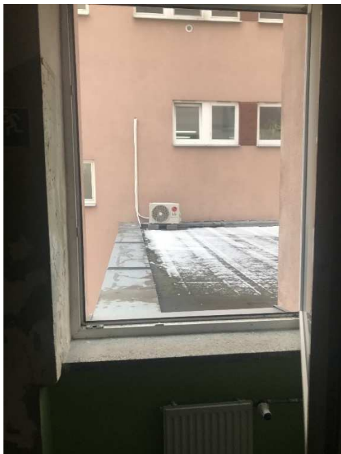
Foto. 10. Widok z kondygnacji 2 klatki schodowej K1C – ściana oddzielenia przeciwpożarowego budynku E z bezklasowymi otworami oraz z izolacją palną
