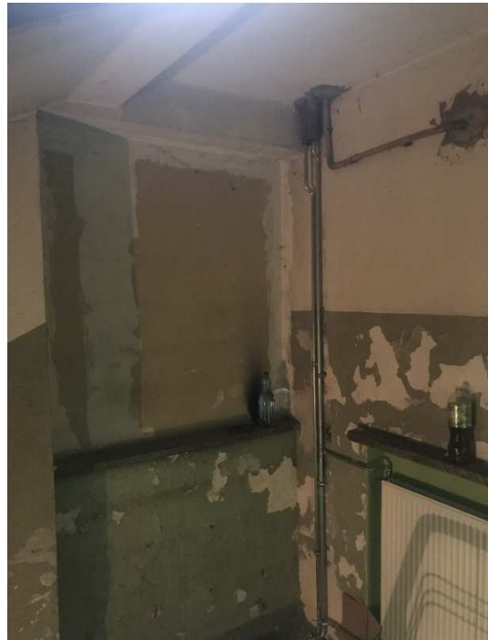
Foto. 6. Wypełnienie otworu stanowiącego obudowę klatki schodowej bez wymaganej klasy odporności ogniowej (R)EI 60 – do usunięcia w etapie I
