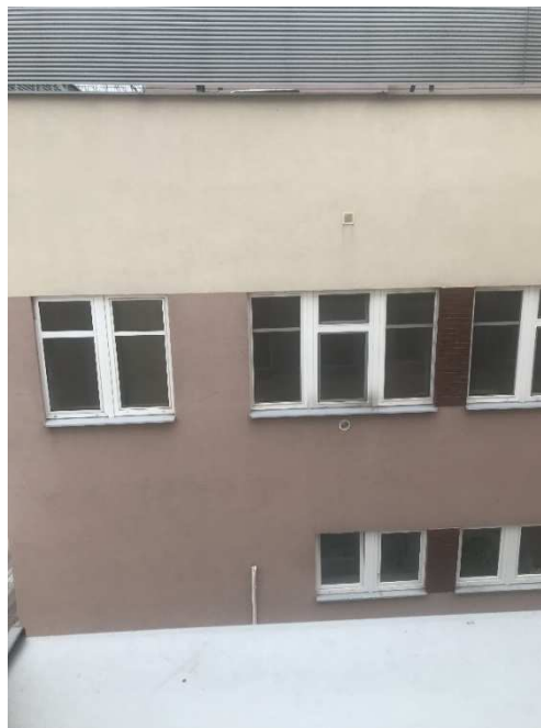
Foto. 11. Widok z kondygnacji 5 klatki schodowej K1C – ściana oddzielenia przeciwpożarowego budynku E z bezklasowymi otworami oraz z izolacją palną
