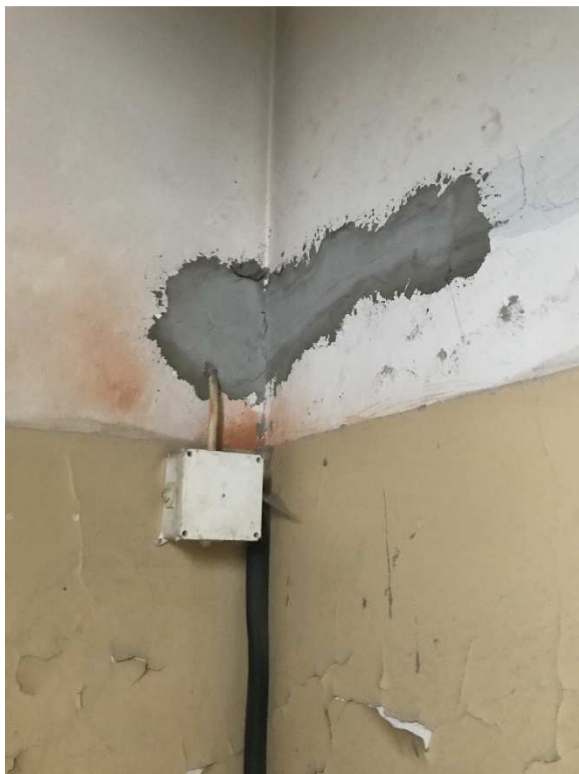
Foto. 8. Brak przejścia ppoż. przez ścianę stanowiącą obudowę klatki K3C – do usunięcia w etapie I
