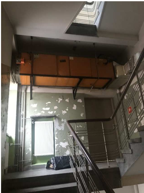
Foto. 3. Urządzenie wentylacyjne w K1C bez obudowy w klasie (R)EI 60 – do pozostawienia
