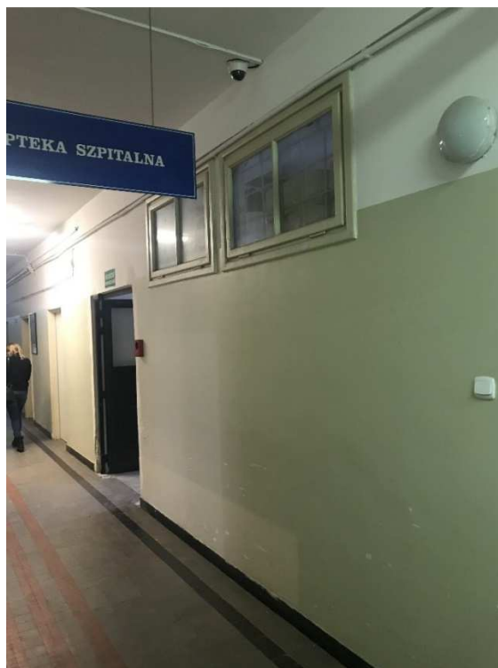
Foto. 2. Bezklasowe przeszklenia w obudowie drogi ewakuacyjnej przy klatce schodowej K1C
